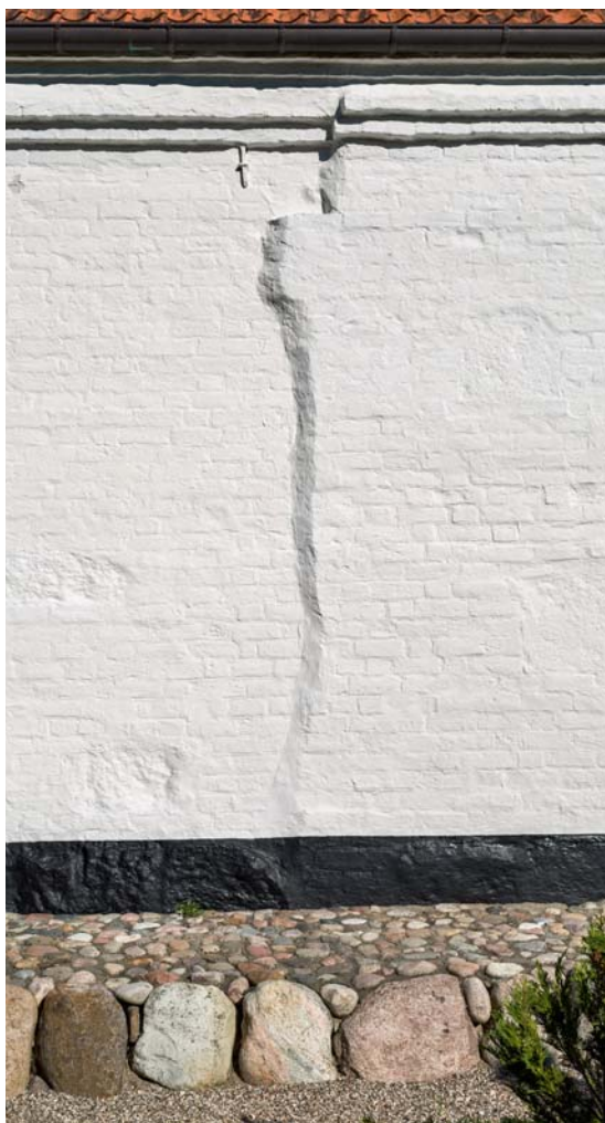
Fig. 7. Byggestop mellem langhusets østre og vestre del på bygningens sydside (s. 3486). Foto Arnold Mikkelsen 2015. – Interrupted construction between east and west part of nave on south side of building.
