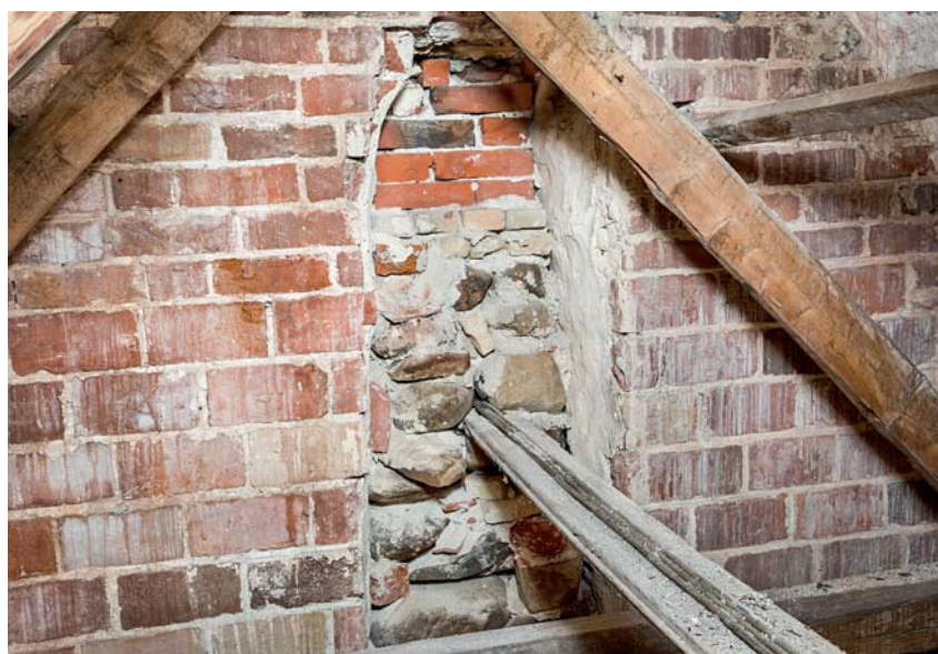
Fig. 41. Indersiden af langhusets vestgavl med murværk af rejste munkesten (s. 3486) samt sekundær, nu tilmuret, adgang fra tårnet (s. 3491). Foto Arnold Mikkelsen 2016. – Inside wall of west gable of nave with medieval brick masonry and secondary, now bricked-up access from the tower.
