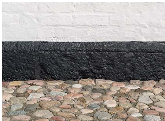
Fig. 39. Genanvendte romanske sokkelsten under det senmiddelalderlige langhus (s. 3485). Foto Arnold Mikkelson 2015. – Re-used Romanesque foundation stone under the Late Medieval nave.
